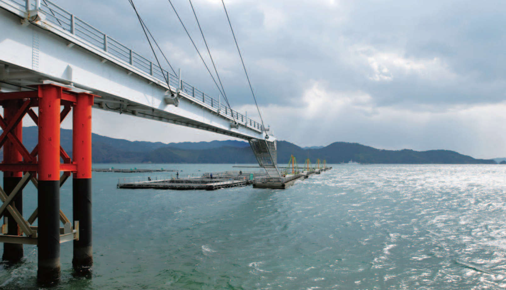
斜張橋と展望台が整備された「シーロード八幡浜」。橋の下にある釣り施設「おさかな牧場」では、いけすに放流されているタイ、アジ、ハマチなどを釣ることができる。
