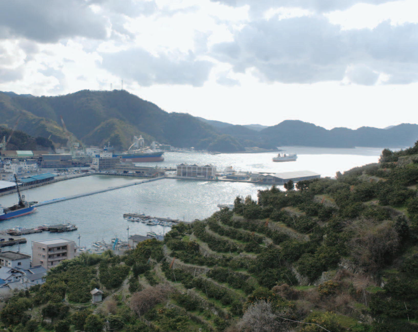
迫りくるような山の斜面に囲まれた八幡浜港は、河口のデルタ地帯に発展した港湾。手前は水産魚市場のある内港地区、奥に見えるフェリーターミナル周辺では拡張工事が進められている。
